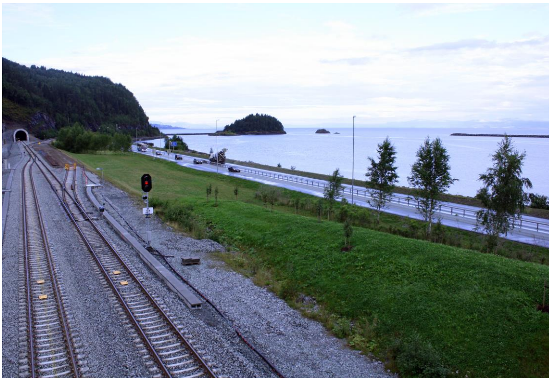
Figur 3-4. Bildet viser plasseringen av eksisterende jernbanelinjer og jernbanetunnel sett i forhold til dagens E6. Muruvik sidespor går over tunnelportalen til E6. Foto: Trondheim Havn, 23.08.11, hentet fra https://no.wikipedia.org/wiki/Geving%C3%A5sen_tunnel .
