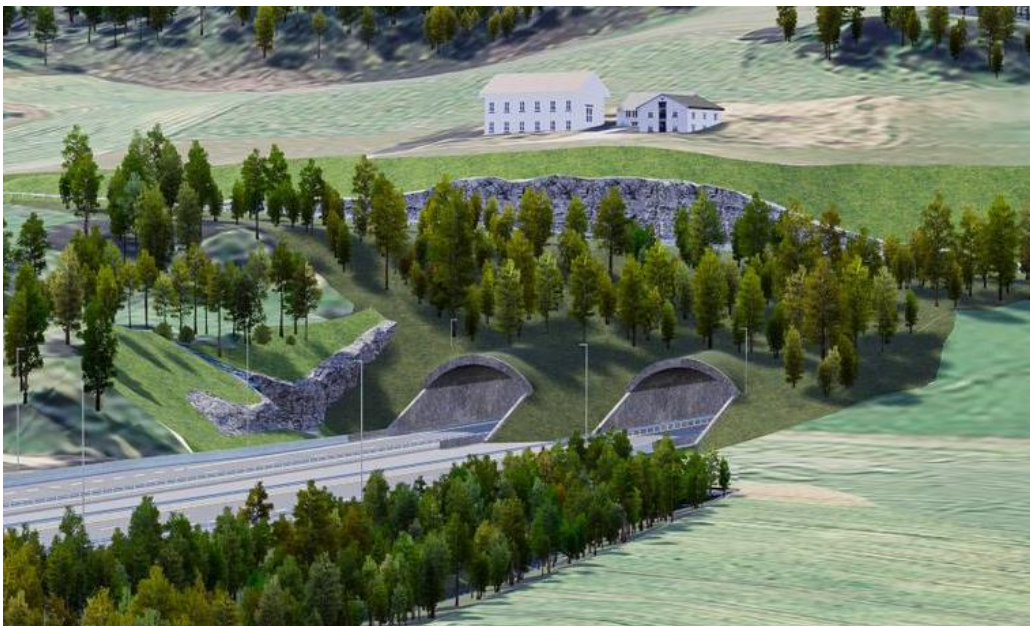
Figur 45: Tunnelportaler på Holan, Forbordsfjelltunnelen, portaler sør.
